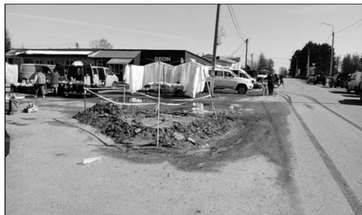
ствии будут убраны. Раскопанное полотно закроем тем материалом, который был изначально уложен на данном участке дороги. Если место прорыва изначально было уложено щебнем - значит, и точку раскопок будем укрывать таким же материалом. Ну а если при устранении водяной аварии пришлось раскапывать асфальт - как только земля перестанет "дышать", на месте раскопок будет восстановлено дорожное покрытие в асфальтовом испол-
