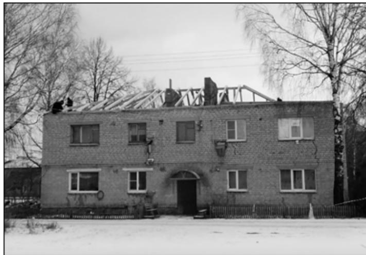
но. Можно заменить поломанный шифер, и протечки на какое-то время будут устранены.
