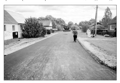
Просевшие и заниженные места подсыпаны песком, а затем слоем шебня толшиной не менее 15 сантиметров. С помощью автогрейдера он аккуратно распределен по всему полотну ремонтируемых улиц. Затем эта подушка прикатана тяжелым дорожным катком.
